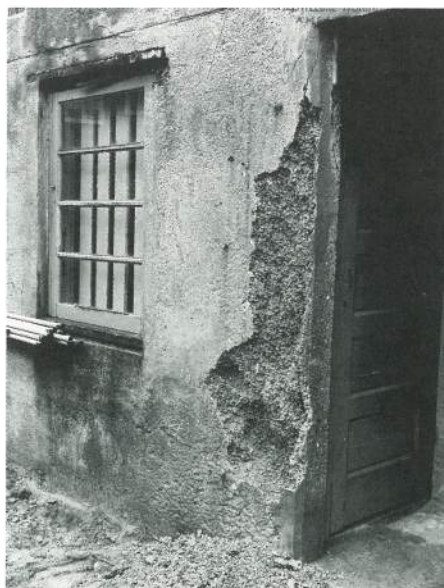
Het korrelbeton liep ook van buiten leeg. (Oogststraat) (foto GDV)
