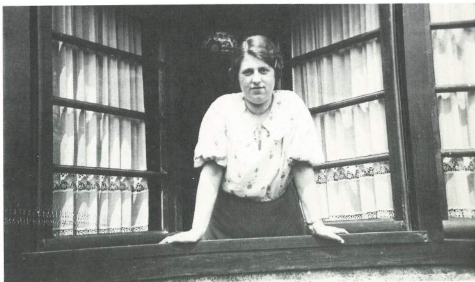
Brede ramen met roeden: lastig lappen, duur in het onderhoud (Zuivelplein)
